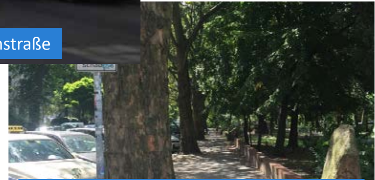
Wenig Gehkomfort, schadhafte Oberflächen und Stolperfallen
