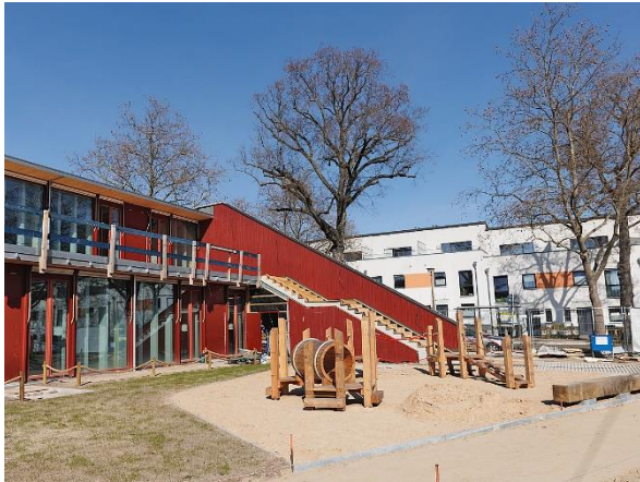
© Bianka Gericke | Baustelle der Kita im März 2024
