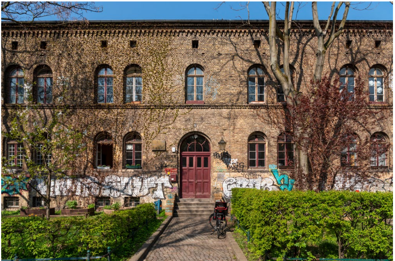
Pestalozzi-Fröbel-Haus vor der Sanierung 2018, Mariannenplatz 3 © Jan-Erik Ouwerkerk
