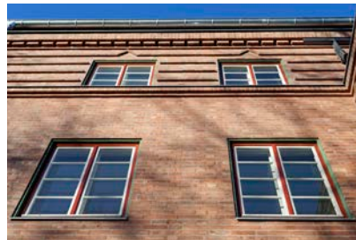
Sanierte Fassade und Fenster
