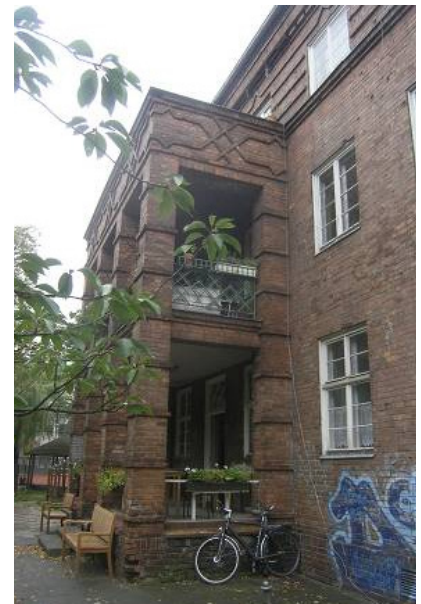
Balkon und Gebäudehülle
