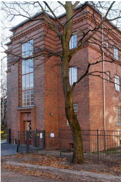
Eingangsbereich des Gebäudes
