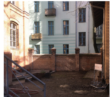
Mauer nach Sanierung
