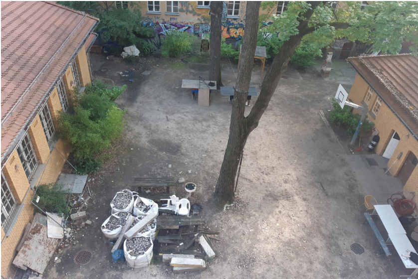
Freifläche vor der Sanierung
