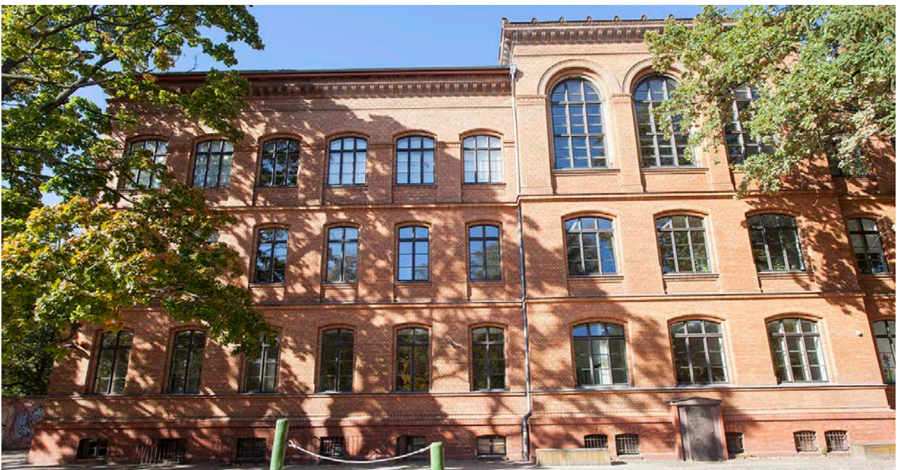
Hofseite des Schulgebäudes
