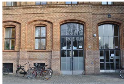
Fensterflächen nach Sanierung
