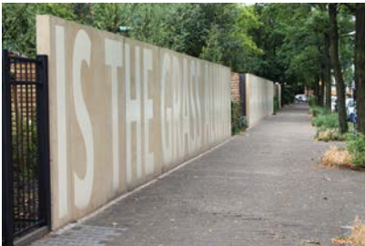
Einfriedung des Grundstücks
