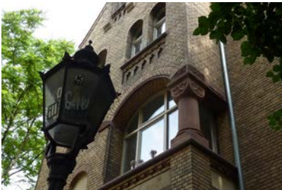
Nordfassade und Fenster
