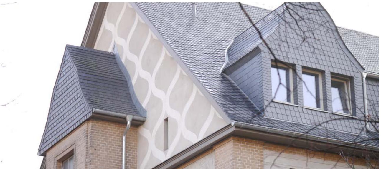
Dachgeschoss nach der Sanierung
