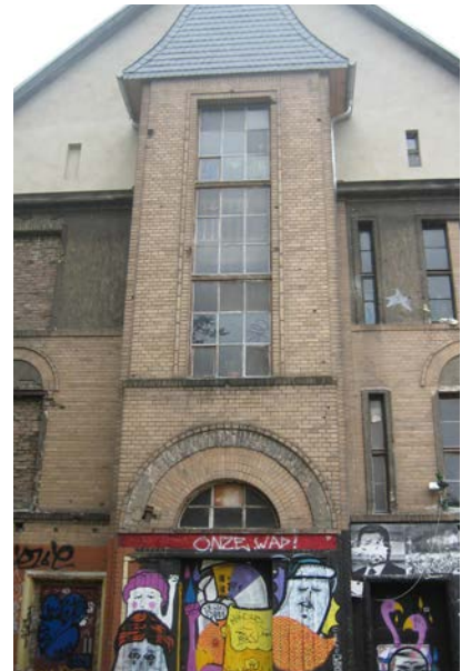
Eingang und Außenfassade
