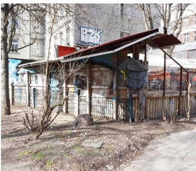
Grenze zum Außenbereich Restaurant
