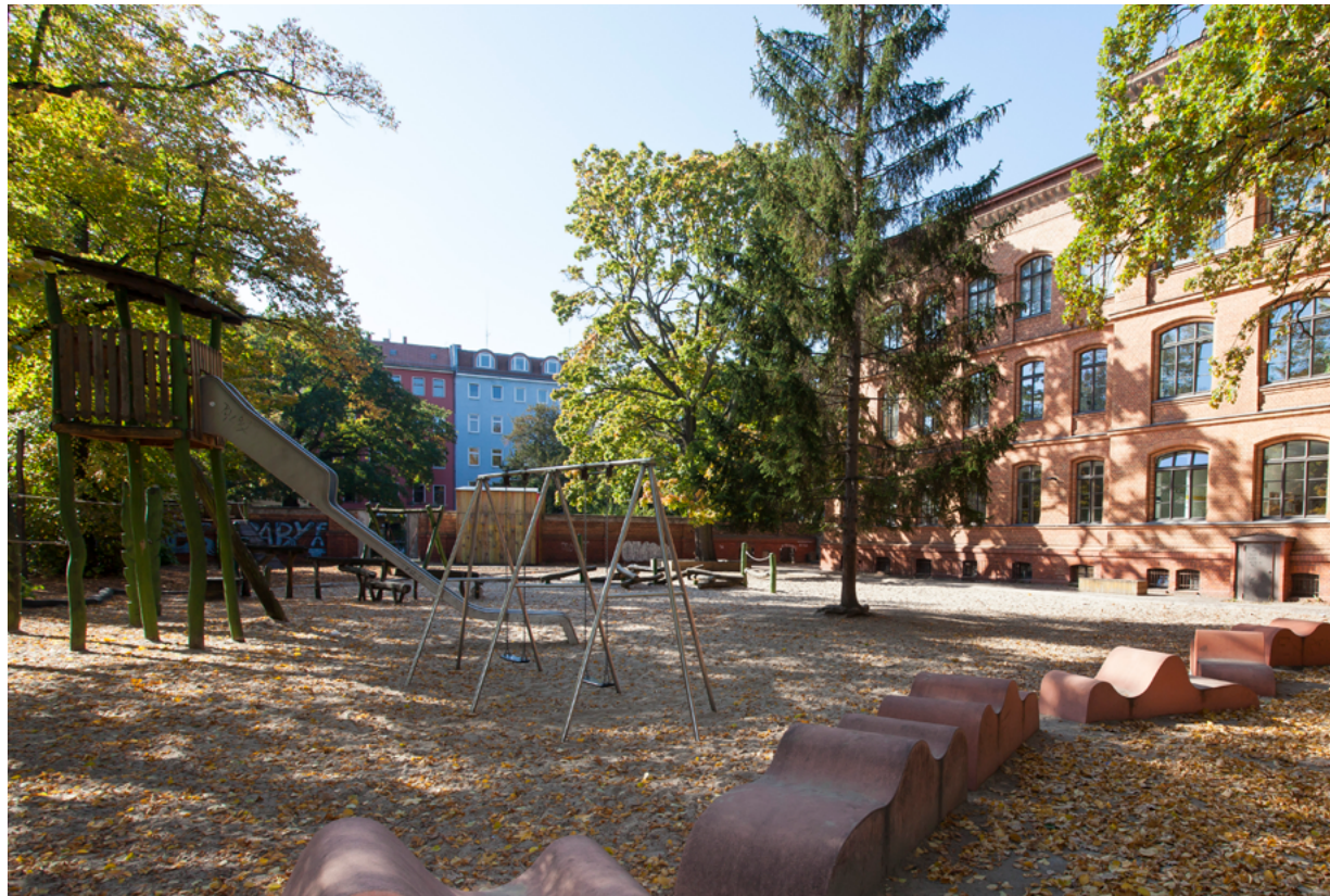
Die Nürtingen-Grundschule inkl. Hof nach der Sanierung © Lichtschwärmer - Christo Libuda
