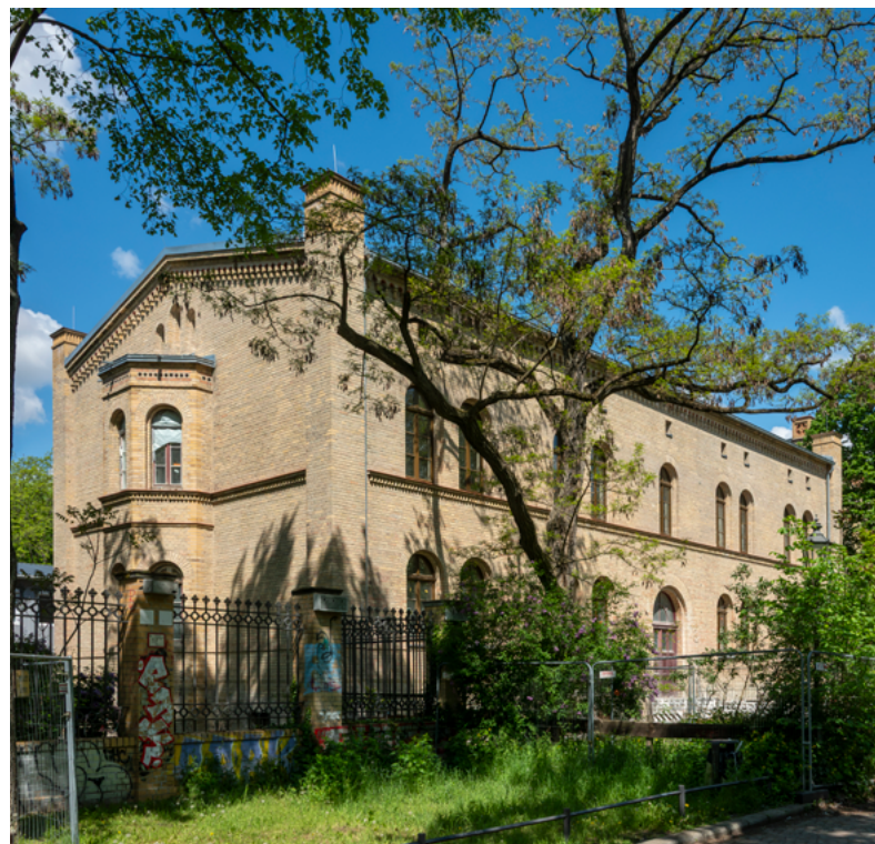
Mariannenplatz 3: Außenansicht © Erik-Jan Ouwerkerk
