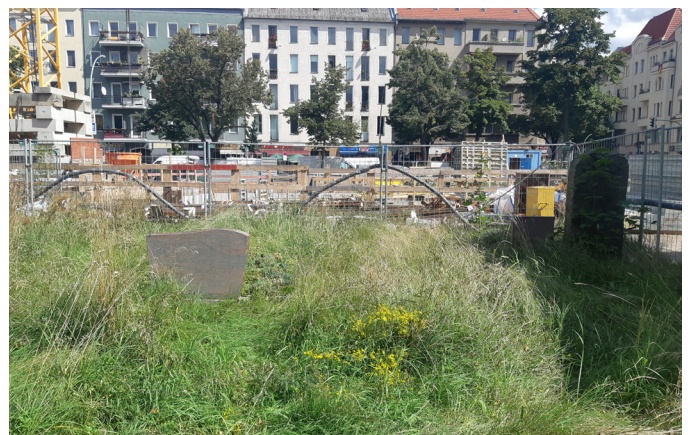
Baustelle Schöpflin-Stiftung auf Jerusalem V
